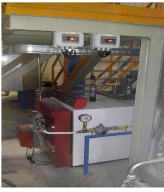
Calentamiento independiente de dos depósitos de silicato, con sondas PT100, termostatos digitales independientes para cada depósito, válvulas de zona y grupo térmico de 2 potencias para el ahorro energético de 70 KW.
